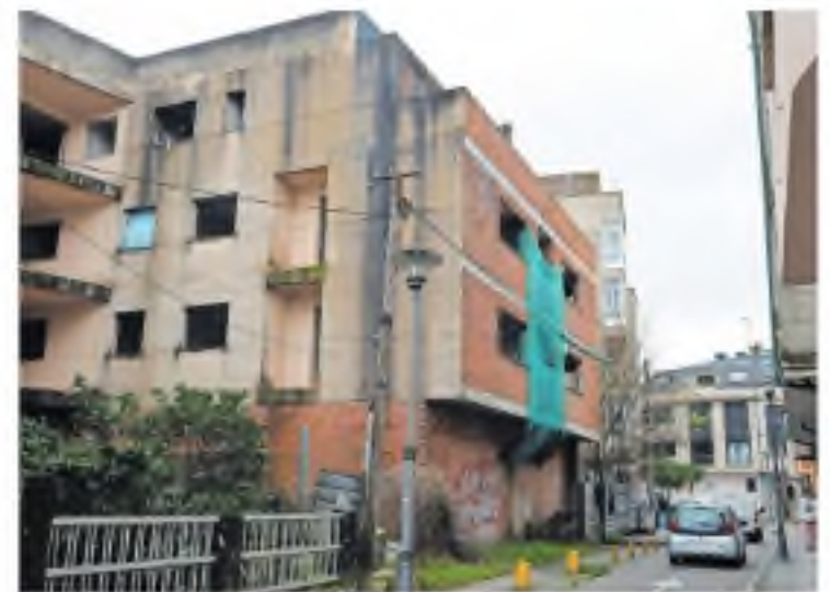
El edificio registrado ayer en Cangas (Pontevedra). A. IRAGO (EP)
